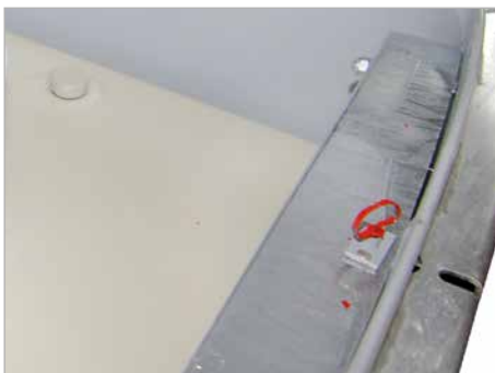
Peilstab für Leckagekontrolle
